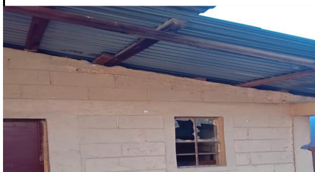
Foto 2: sustitución de estructura de metal de ventana
