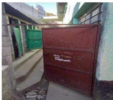
Foto 5: sustitución de puertas
