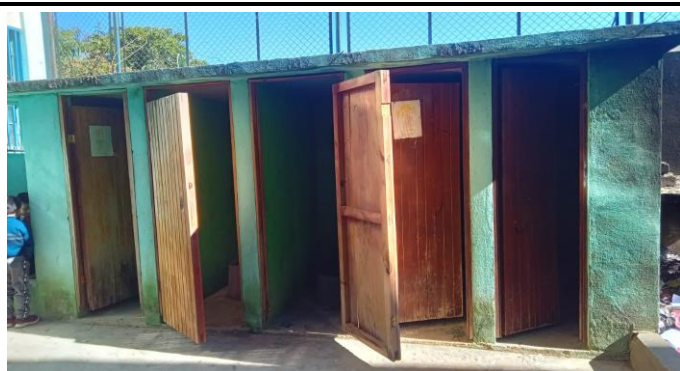
Foto 3: sustitucion de puertas en servicios sanitarios
