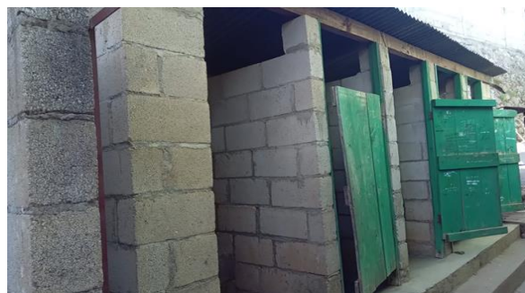
Foto 4: aplaicación de repello se servicio sanitario
