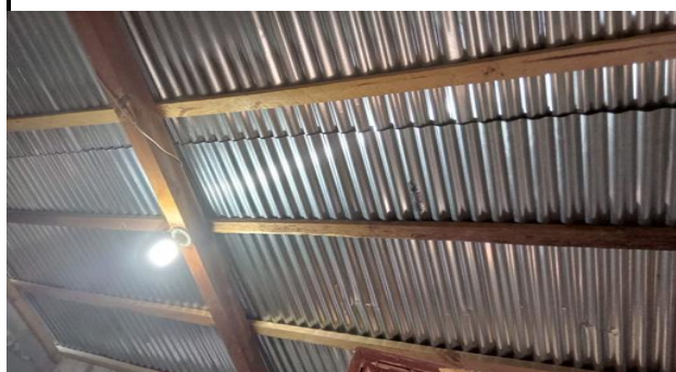
Foto 6: reparacion de sistema electrico
